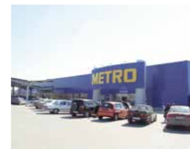
Торговый центр METRO, г. Пермь
