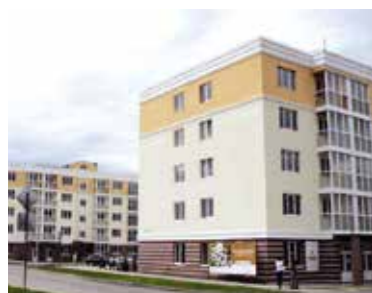
Жилой комплекс «Новый свет», г. Волгоград
