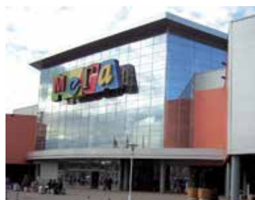
Торговый центр «МЕГА», г. Санкт-Петербург
