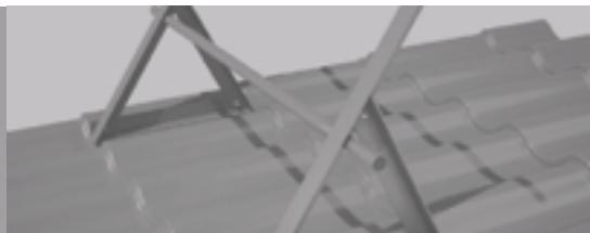
На металличерепицу устанавливают обычно именно трубчатые снегозадержатели. Они задерживают снежные массы больших размеров на крыше. При этом, небольшие части снежного покрова могут беспрепятственно перемещаться вниз, не грозясь причинить вред проходящим мимо людям, либо имуществу, размещённому поблизости.
