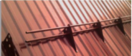
На профнастил можно ставить любой снегозадержатель. Монтаж возможен вниз волны, если профиль меньше 10 см., и вверх волны с помощью специальной пластины.
