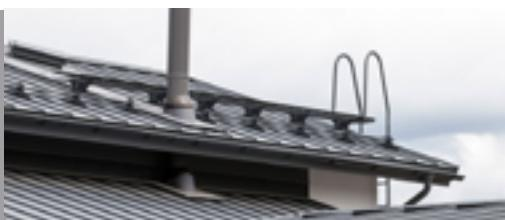
Переходные мостики рекомендуется устанавливать вместе с кровельными лестницами. Установка производится так, чтобы верхние ступени лестницы находились на расстоянии до 30 см. от мостика
