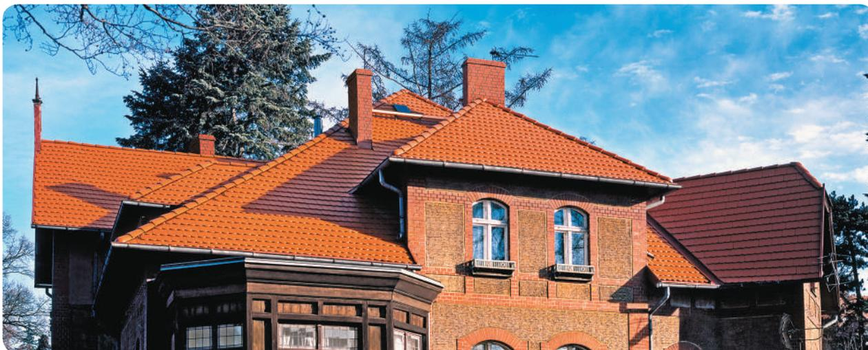
Черепица «Ревива» с плоской поверхностью в форме «бобрового хвоста» пришла к нам из глубины средних веков и в современной интерпретации напоминает о традиционном дизайне кровли.
